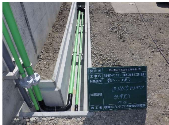
燃料配管設置完了
