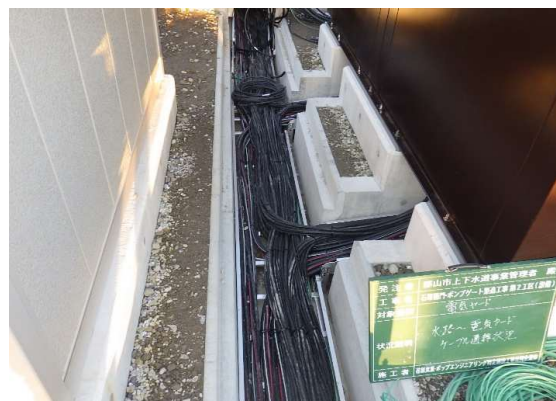
電気ケーブル設置完了
