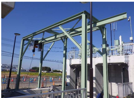
コンテナ吊上装置設置完了
