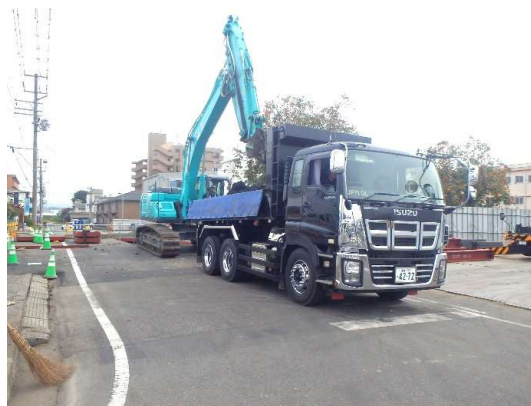
発進立坑 掘削状況
