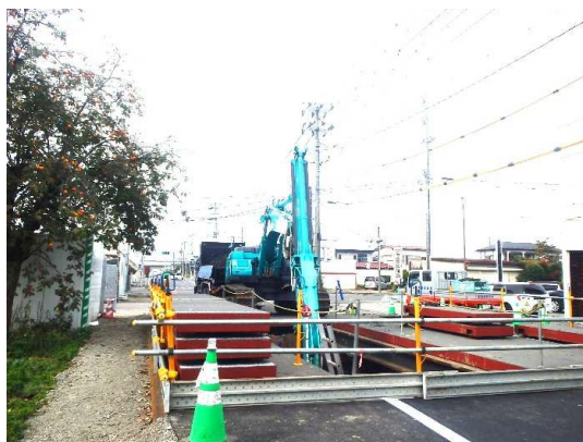
発進立坑 掘削状況
