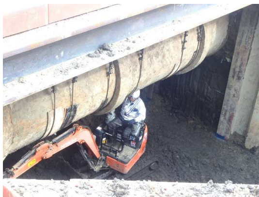
発進立坑 掘削状況
