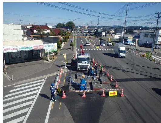
割込立坑 地盤改良工状況
