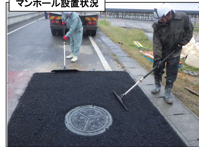
マンホール設置状況
