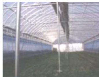
中柱（仮支柱）設置の写真
