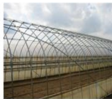
筋交いを入れた写真
