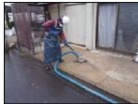
吸引式高圧洗浄
