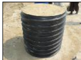
容器の隙間に土を充填
