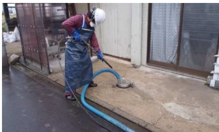
除染作業の様子
