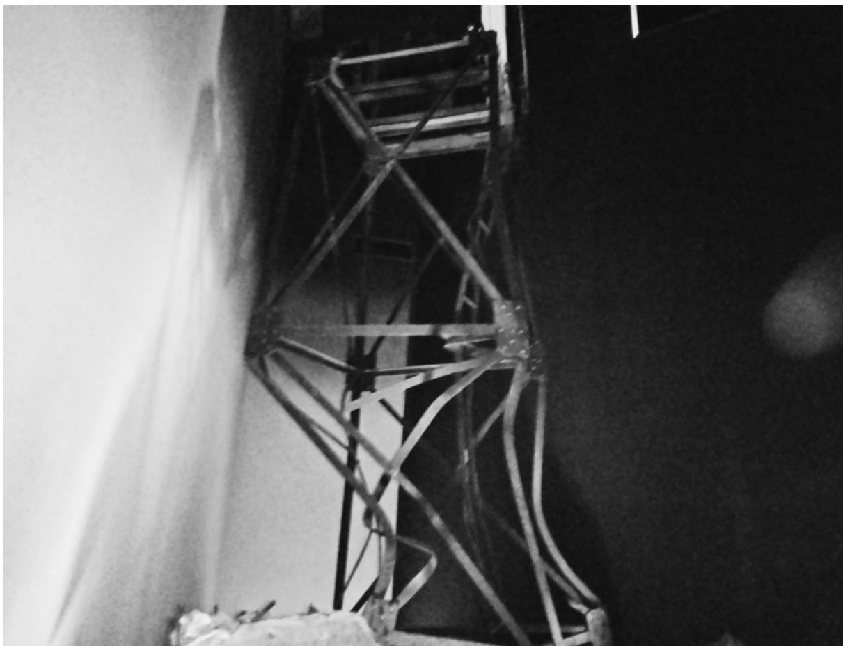
＜ 被爆によりゆがんだ鉄柱 ＞
