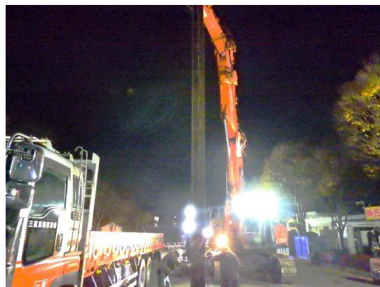
親杭（H鋼）設置状況
