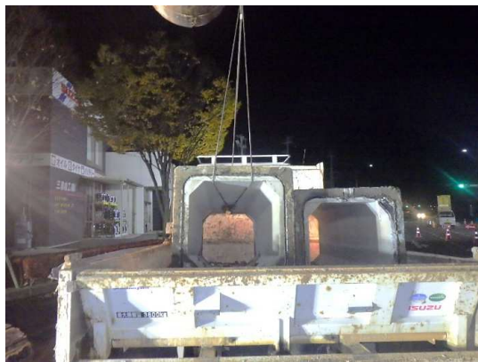
既設管撤去状況
