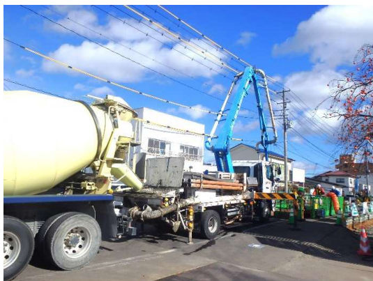
発進立坑 基礎コンクリート打設状況
