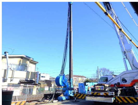
到達立坑 鋼矢板設置状況
