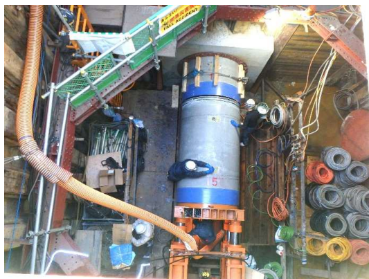
推進管据え付け状況
