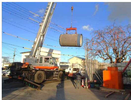
推進管据え付け状況
