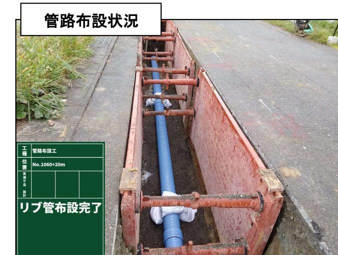
現在、下水管の布設工事が本格的に始まり、「道路の掘削」「下水道管の布設」「埋戻し」「舗装の仮復旧」の流れで施工しております。工事中は車の出入り等、皆様にご不便をおかけしますが、安全第一で進めてまいりますので、ご協力ををお願いいたします。
