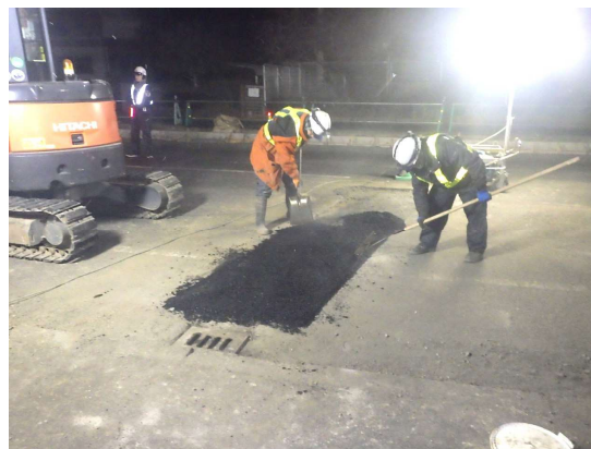
取付管部 舗装仮復旧状況
