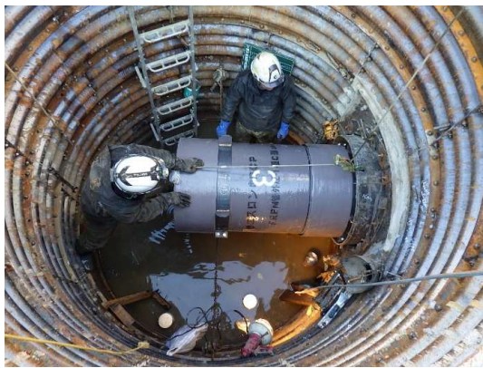
推進管据え付け状況
