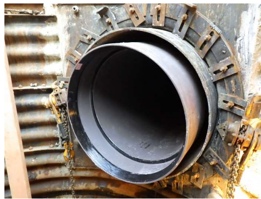
推進管据え付け完了
