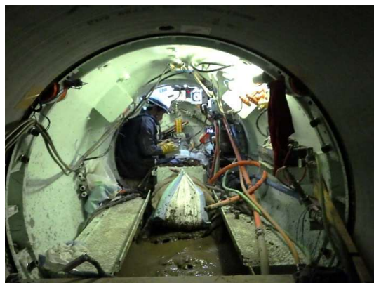
推進内部状況（掘削機）
