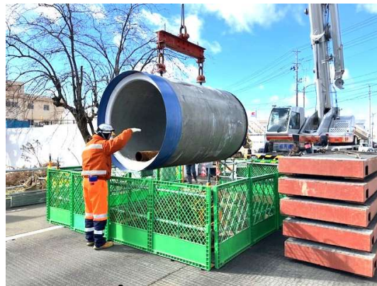
推進管据え付け状況
