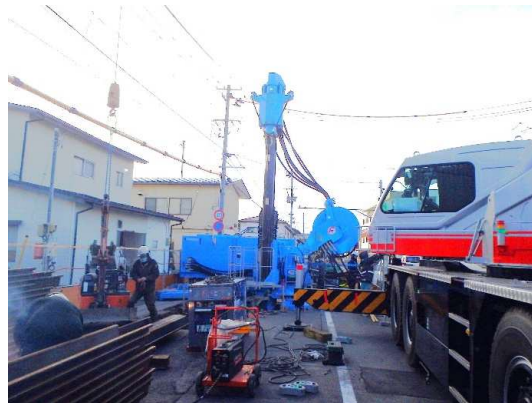
到達立坑 鋼矢板設置状況
