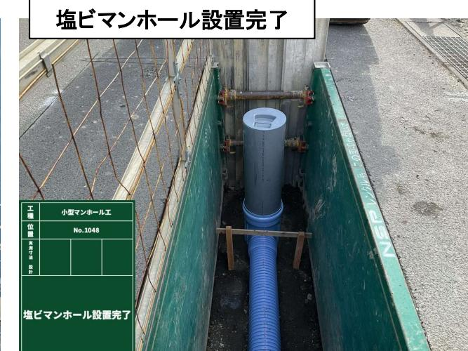
現在、下水管の布設工事が本格的に始まり、「道路の掘削」「下水管の布設」「埋戻し」「舗装の仮復旧」の流れで施工しております。工事中は車の出入り等、皆様にご不便をおかけしますが、安全第一で進めてまいりますので、ご協力ををお願いいたします。
