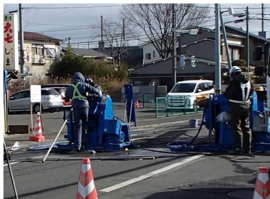
到達立坑薬液注入状況
