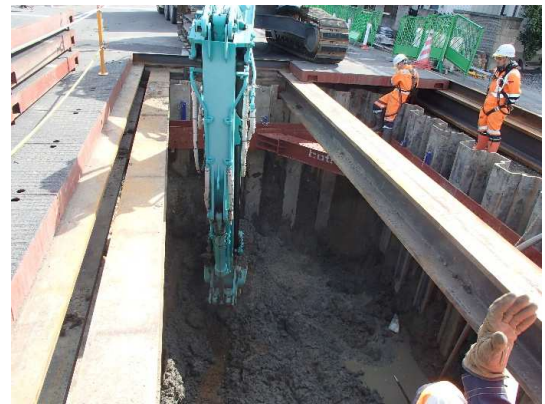
到達立坑掘削状況
