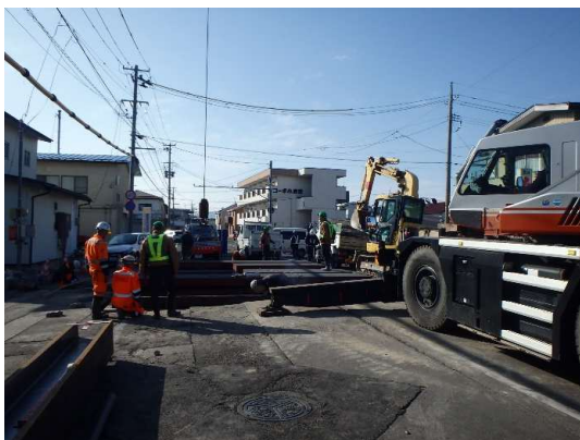
到達立坑覆工板設置状況
