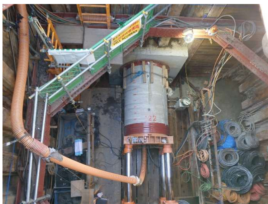
推進管発進状況（発進立坑内）
