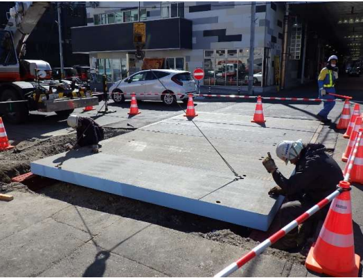
覆工板設置状況
