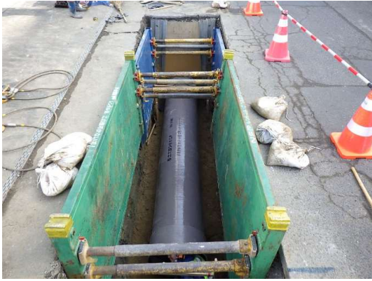
管渠布設状況
