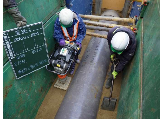
管渠埋戻し状況
