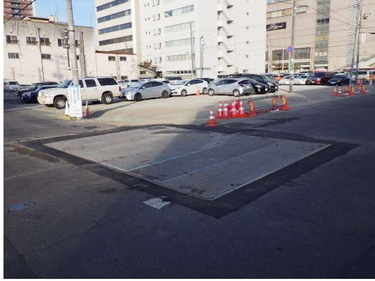
覆工板設置完了
