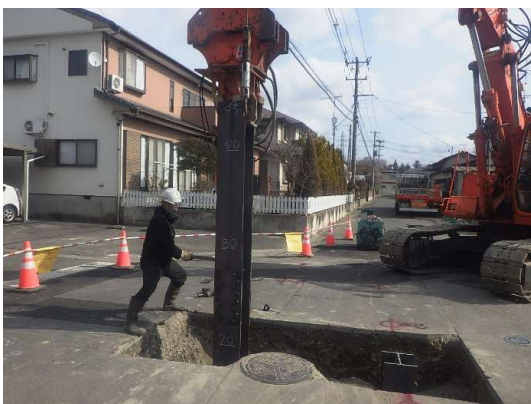
親杭施工状況
