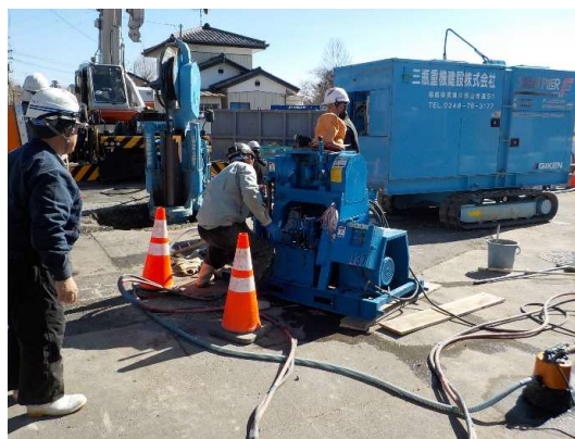
薬液注入施工状況
