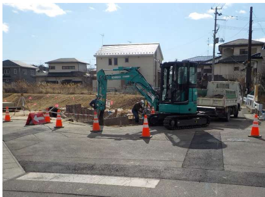
既設管撤去状況
