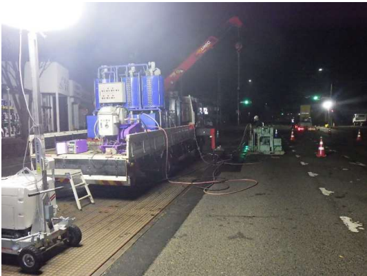
薬液注入状況
