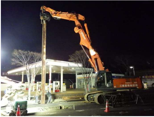
親杭施工状況
