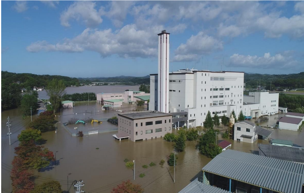
令和元年東日本台風により浸水した富久山クリーンセンター(提供：スペースワン)
