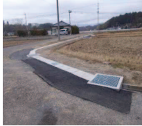
市道「樋下外堀線」 (延長：約65m)
