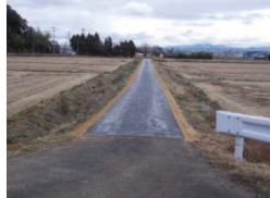
市道「池下1号線」 (延長：約160m)
