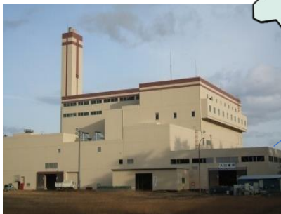
河内クリーンセンター
