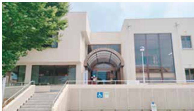
～郡山市男女共同参画センター（さんかくプラザ）～ ※長寿命化改修工事後
