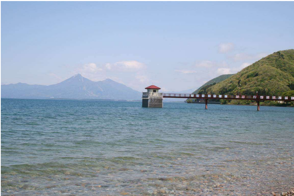
猪苗代湖と浜路取水塔
