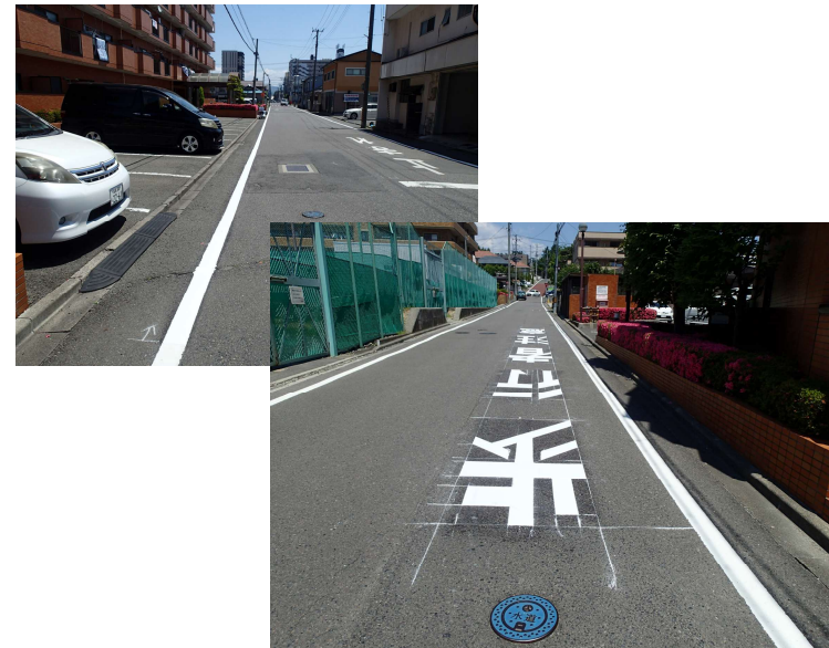
令和3年度施工
