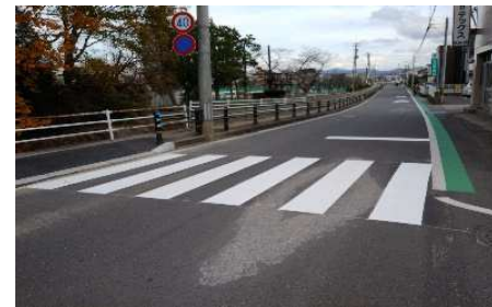
令和元年度施工
