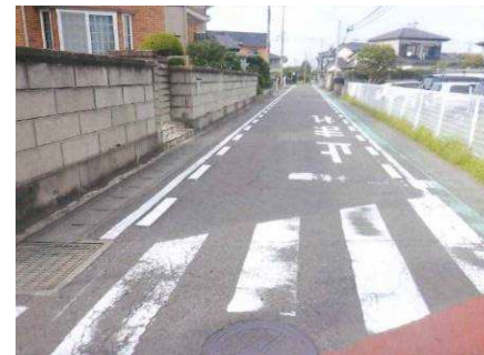
令和5年度施工
