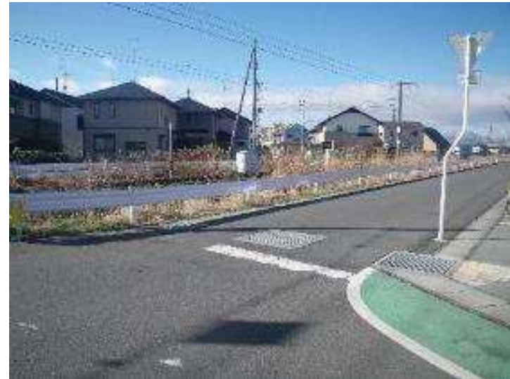
平成29年度施工
