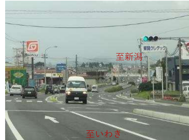
対策後 (平成25年度施工)
