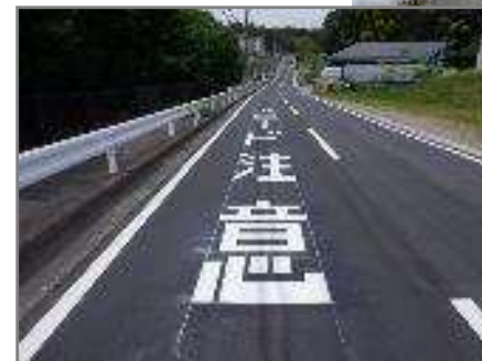
令和6年度施工
