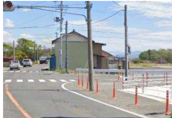
平成27年度施工
