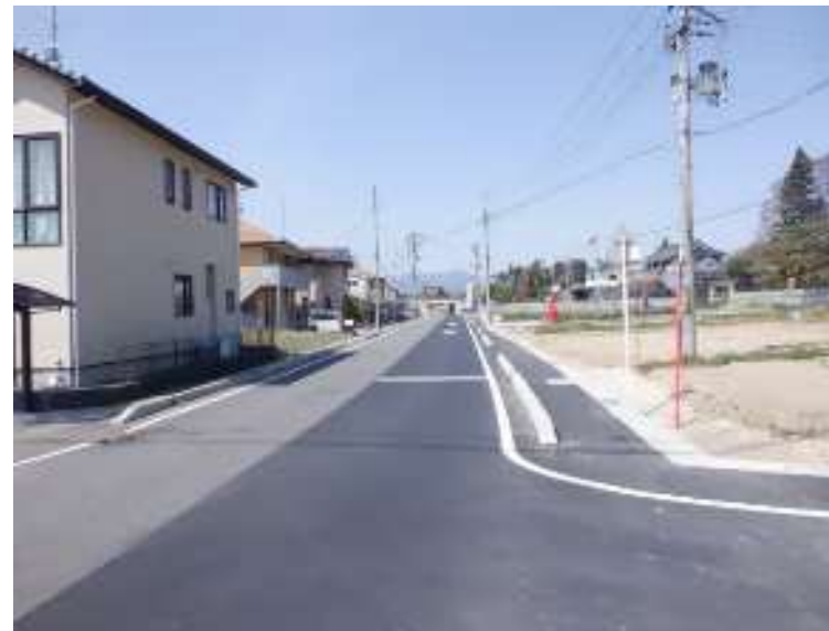
令和4年度施工
