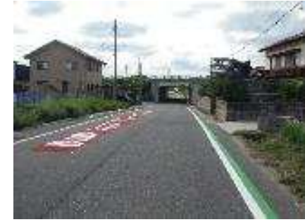
対策後 平成30年度施工
