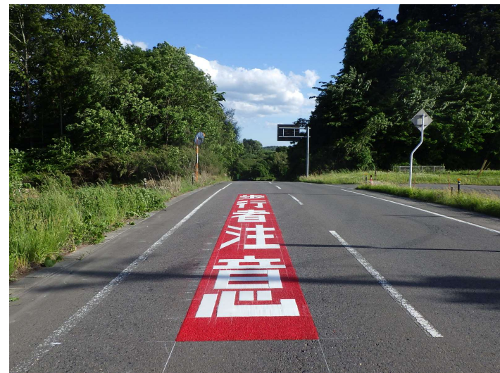
令和元年度施工
