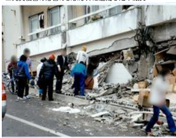
▲潰れた一階部分で取り残された市民の救出活動状況
