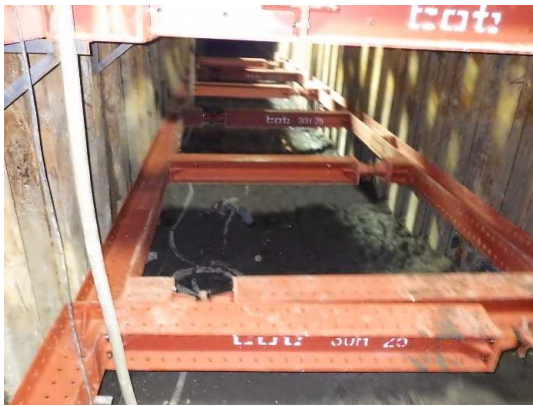
切梁設置完了
