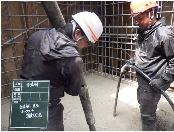
合流桝：底版コンクリート打設状況
