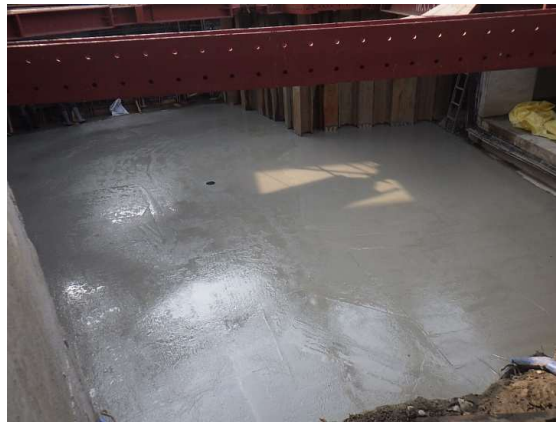
合流桝：底版コンクリート打設完了
