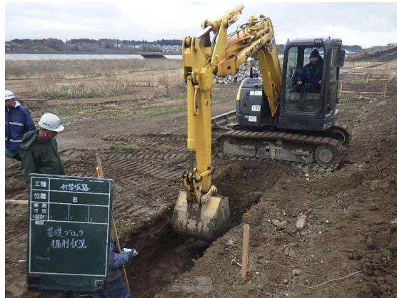
付替坂路：床掘削状況
