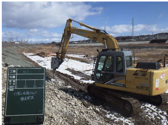
付替坂路：既設護岸撤去状況
