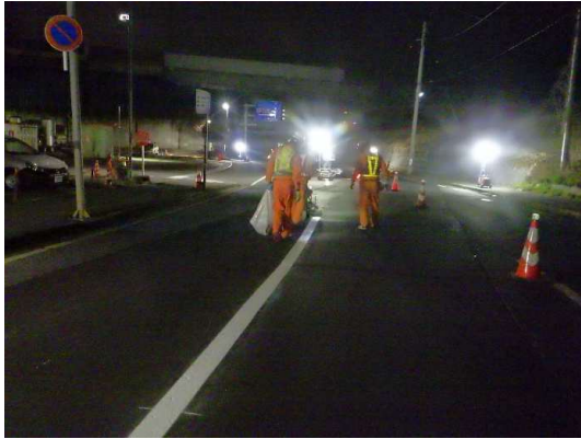
区画線復旧状況
