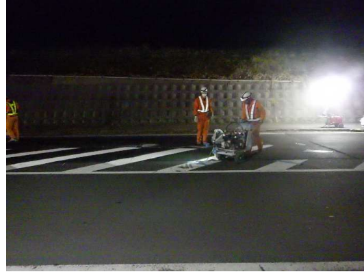
区画線復旧状況
