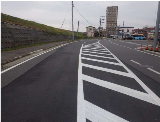
区画線復旧完了
