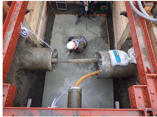
基礎コンクリート打設状況(立坑内)
