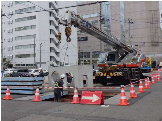
管渠取付壁設置状況(特殊人孔)
