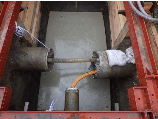
基礎コンクリート打設完了(立坑内)
