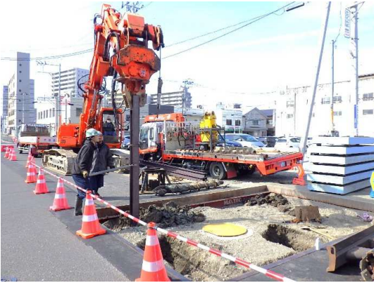
親杭設置状況
