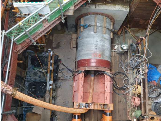
推進工状況（発進立坑内）
