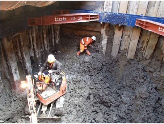
到達立坑掘削状況
