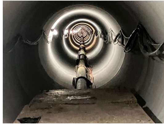
推進管内部状況
