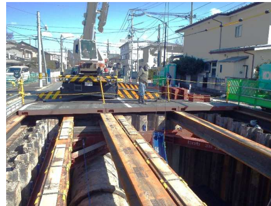
到達立坑仮設工状況
