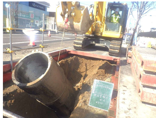
既設管撤去状況
