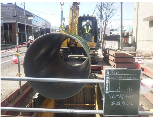
管渠布設状況
