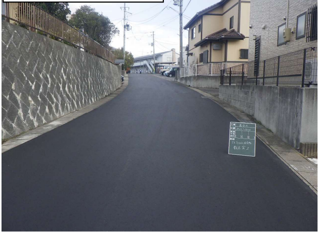
復旧完了状況
