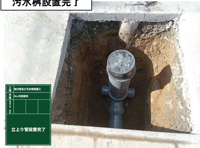
汚水柵設置完了
