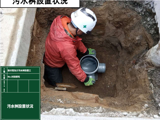
汚水柵設置状況
