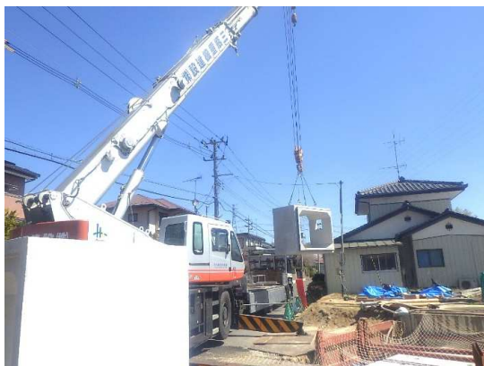
ボックスカルバート布設状況
