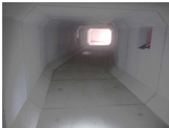
ボックスカルバート布設完了(内部)
