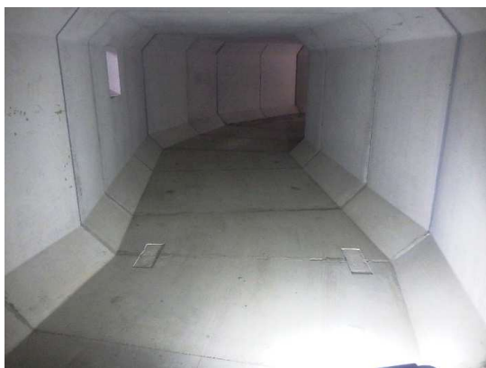
ボックスカルバート布設完了(内部)
