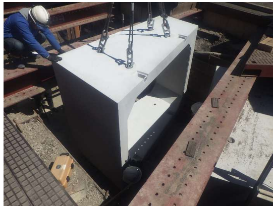
ボックスカルバート布設状況
