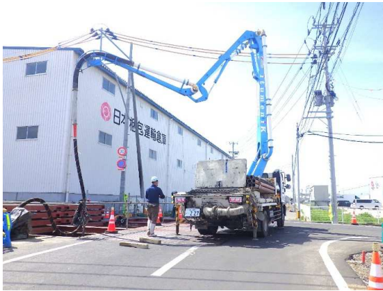
合流柵：コンクリート打設状況
