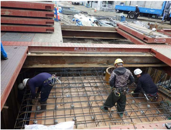
合流柵：鉄筋組立状況
