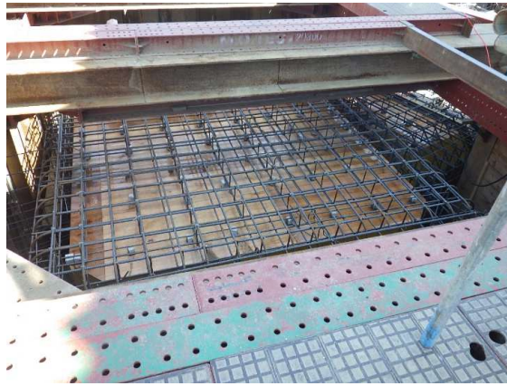
合流柵：鉄筋組立完了
