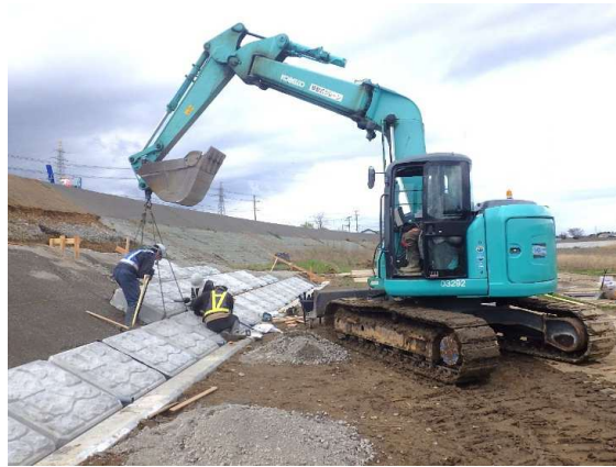
付替坂路：ブロック設置状況
