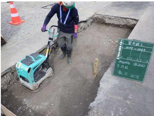
埋戻し転圧状況
