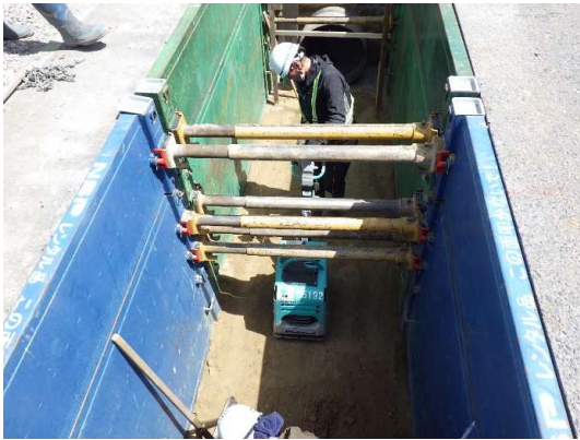
砂基礎転圧状況
