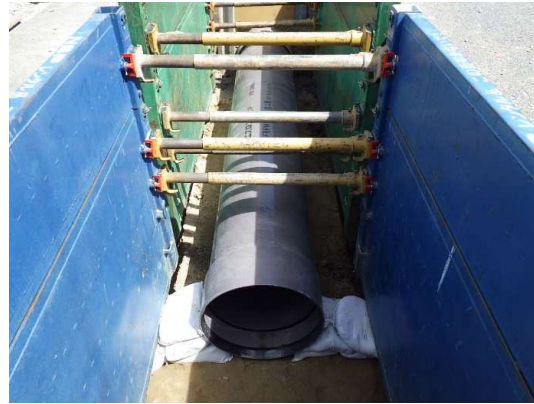
管渠布設完了
