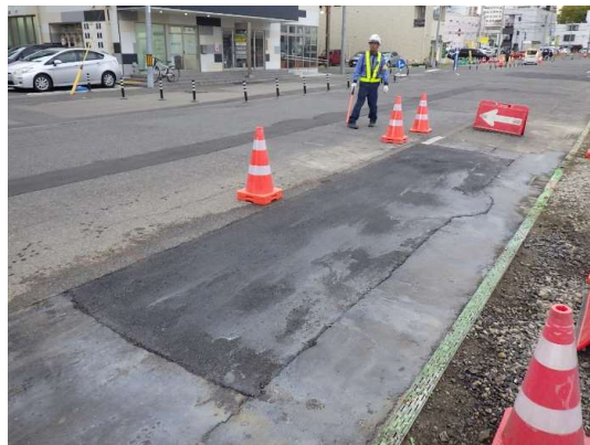
舗装仮復旧完了
