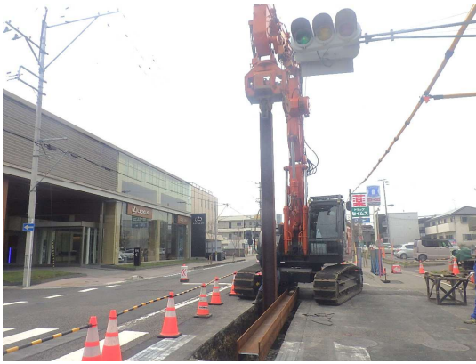
親杭圧入状況
