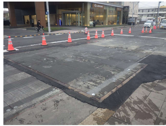
覆工板設置完了
