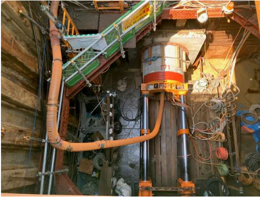
推進工状況（発進立坑内）
