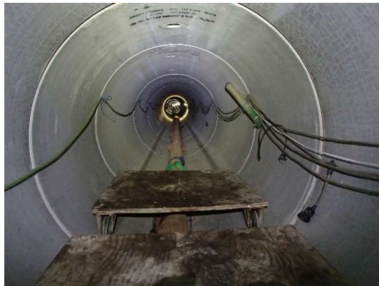
推進管内部状況(440m/474m地点)
