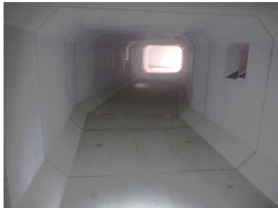
ボックスカルバート布設完了(内部)
