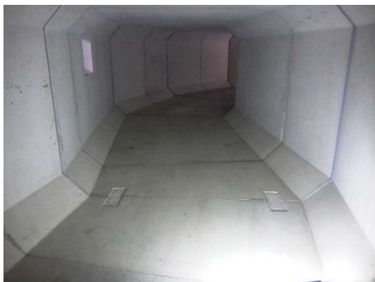
ボックスカルバート布設完了(内部)
