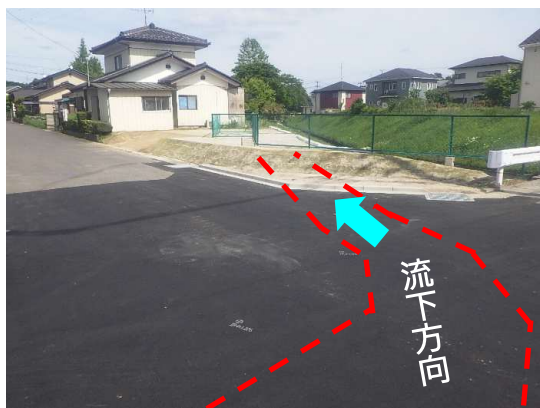
舗装仮復旧完了
