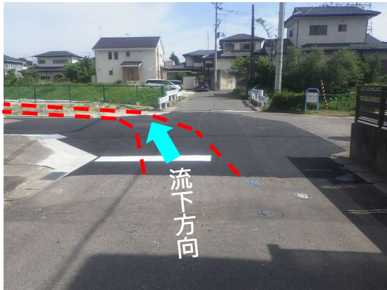
舗装仮復旧完了
