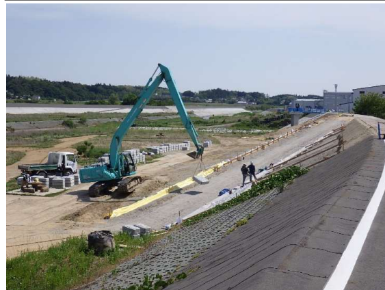
付替坂路：護岸施工状況
