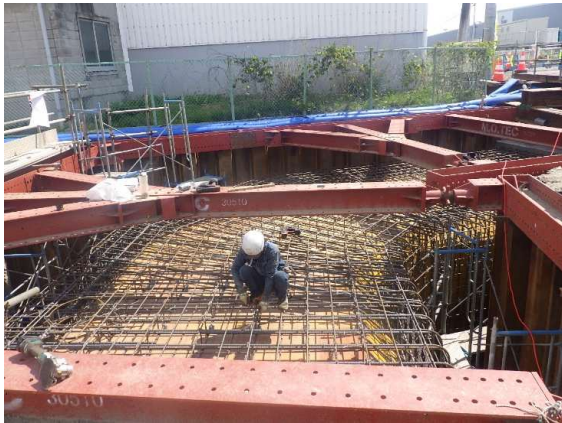
接続水路：鉄筋組立状況
