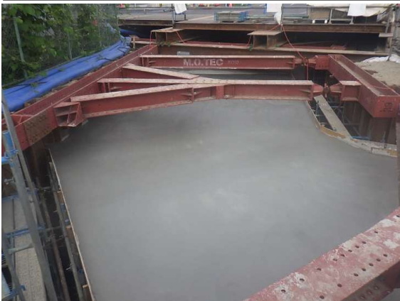
接続水路：コンクリート打設完了
