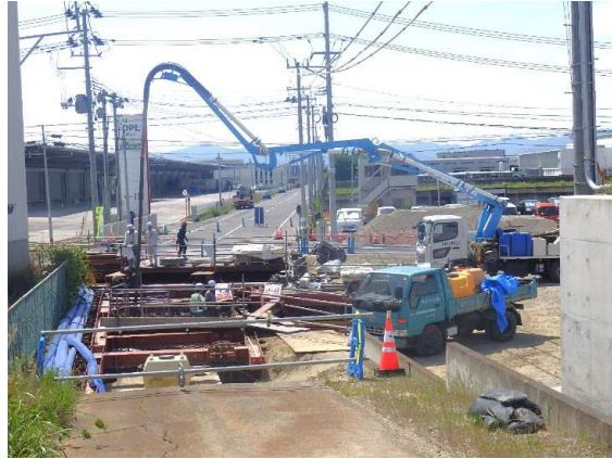
接続水路：コンクリート打設状況
