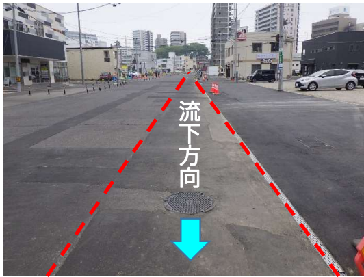
舗装仮復旧完了
