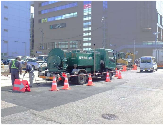
管渠内清掃状況
